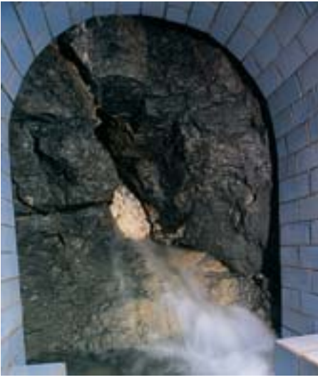
▲ Im Norbertusheimstollen in Zell sieht man das klare Grundwasser direkt aus dem Fels strömen.
