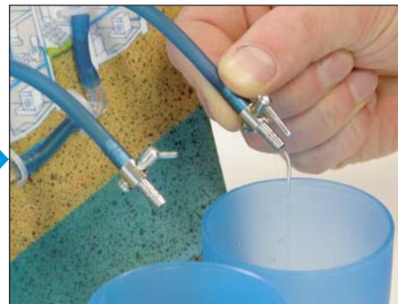
8. Wasserhähne aufdrehen. Wasser bitte nicht trinken wegen möglicher Verkeimung!
