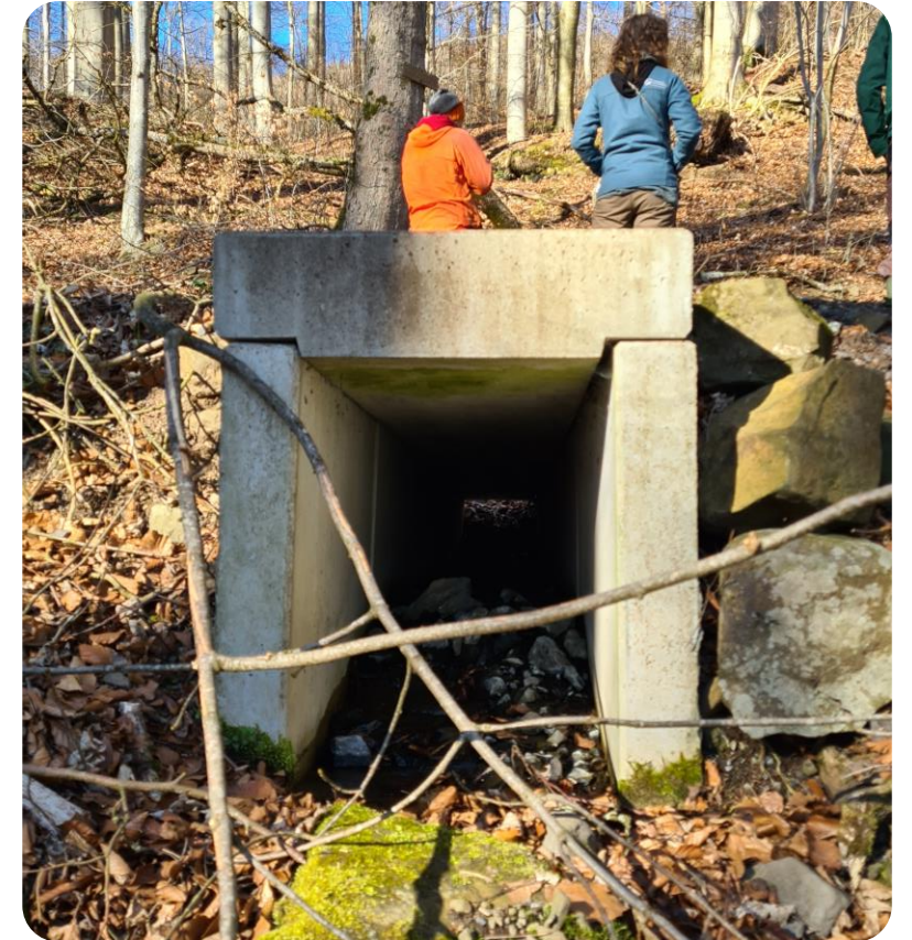
Bei Notwendigen Durchlässen im Quellbereich werden U-Profile genutzt, die ein Zurückwandern ins Grundwasser erlauben. Foto: Lisa Knur
