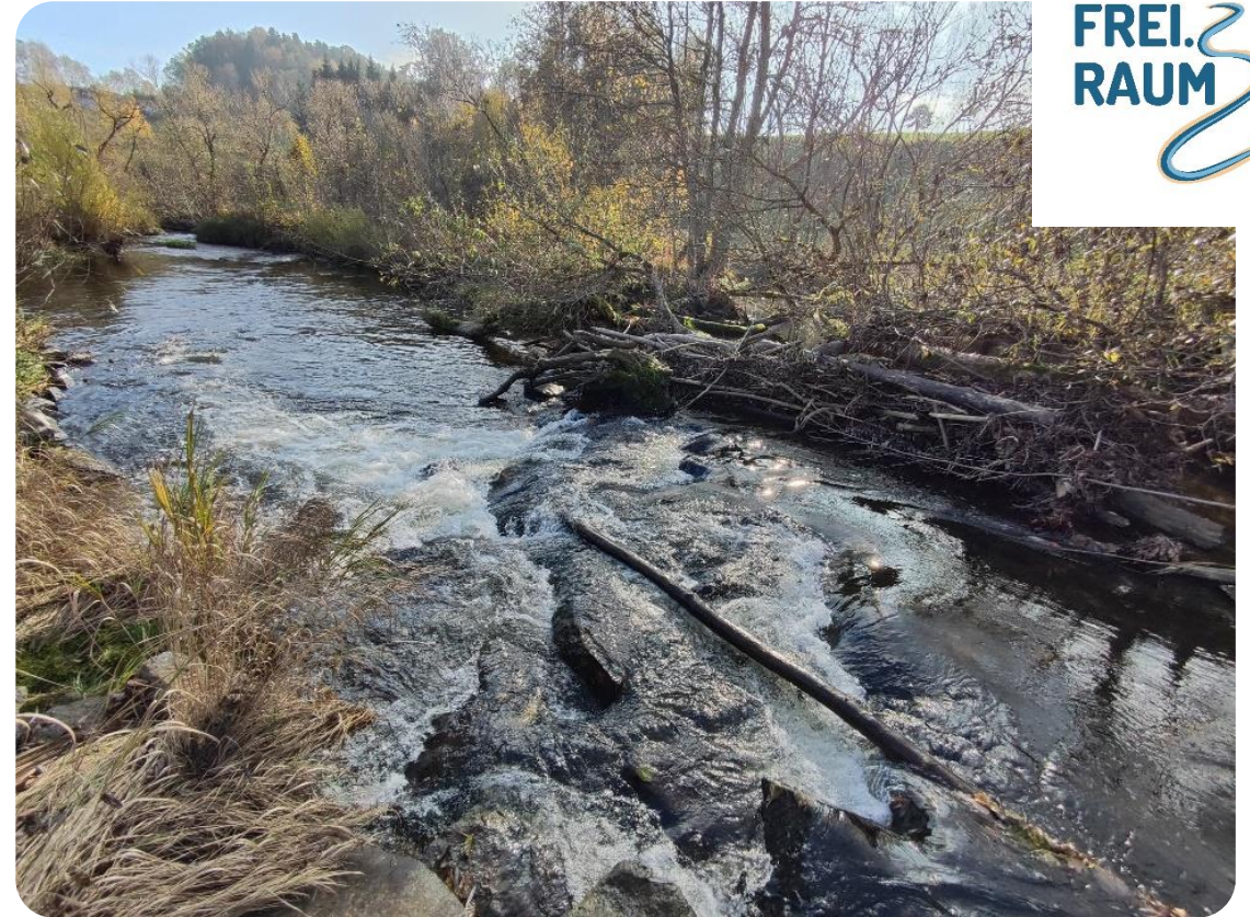
Zustand nach dem Rückbau der Mitternachtsmühle, LFV Bayern, Katharina Amann
