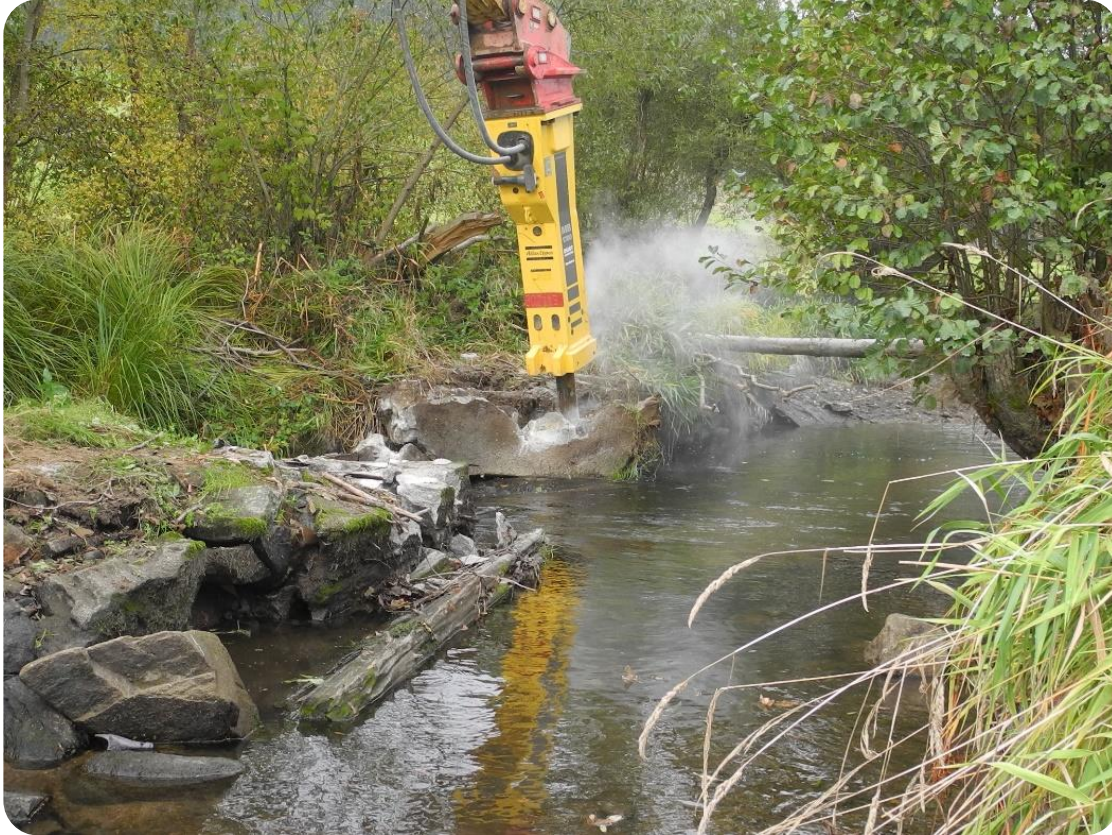
Rückbau der Mitternachtsmühle, LFV Bayern, Stefanie Schütze
