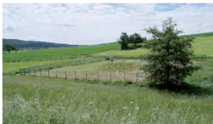
► Um den Brunnen vor Verunreinigungen zu schützen, ist der sogenannte „Fassungsbereich“ immer eingezäunt.
